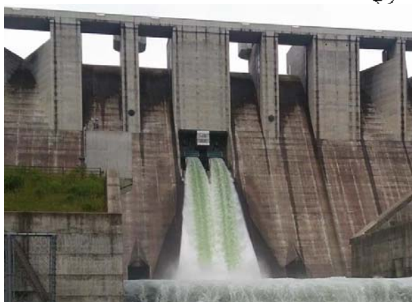
苫田ダムの放流状況
