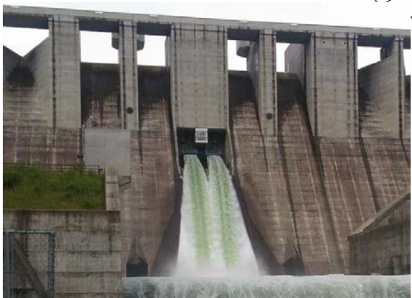
苫田ダムの放流状況
