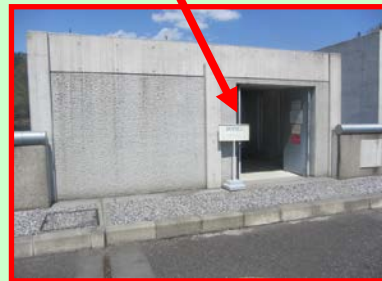
堤体見学室入口
