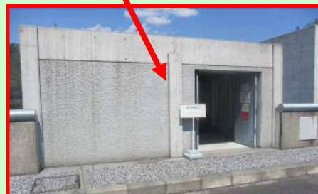
堤体入口(見学不可)
