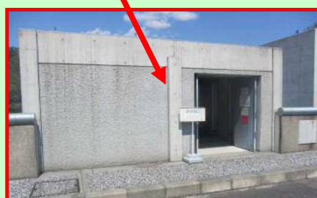
堤体入口(見学不可)
