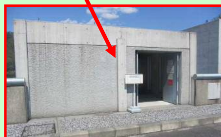
堤体入口(見学不可)
