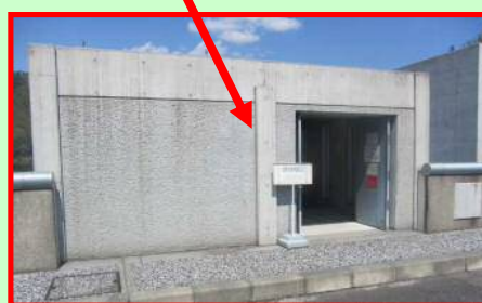
堤体入口(見学不可)
