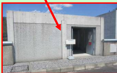
堤体入口(見学不可)
