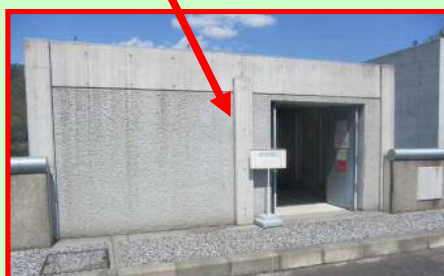
堤体入口(見学不可)
