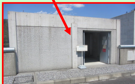
堤体内 入口(見学不可)
