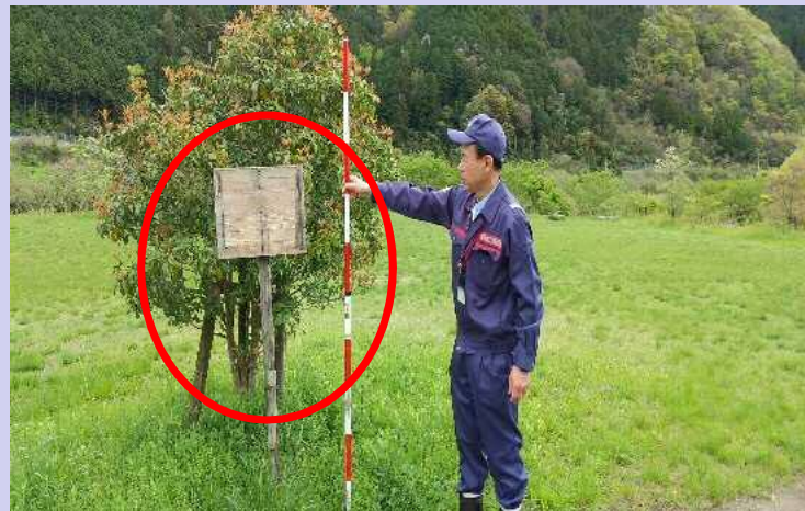
看板の注意表示が剥がれていた
