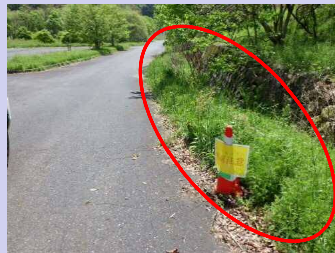
コーンと路肩注意表示を設置
