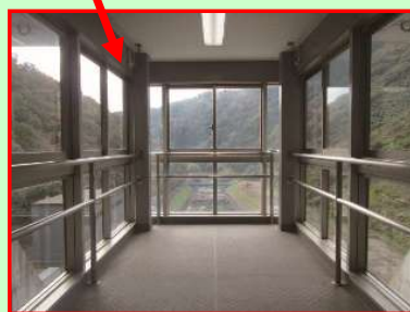
ダム堤体内見学施設(見学不可)
