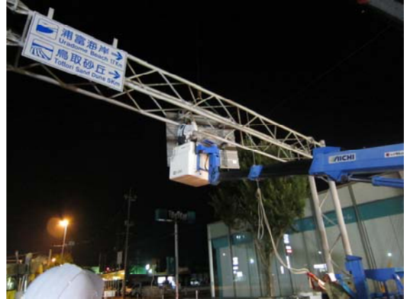
既設の梁から、標識を取り外します
