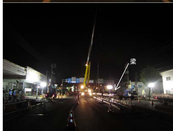
道路を規制して、梁(看板が取り付けられる部分)を組み立てます
