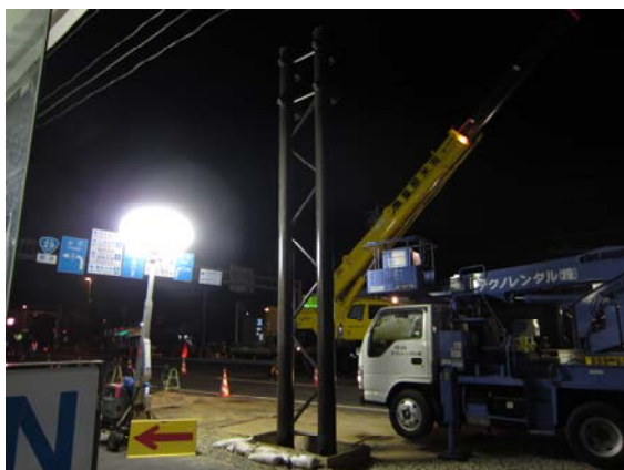
まず新しい標識柱の柱部分を建てます
