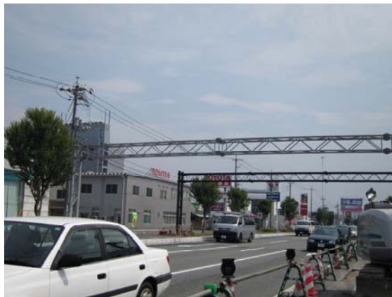
標識がすべて撤去された状態です
