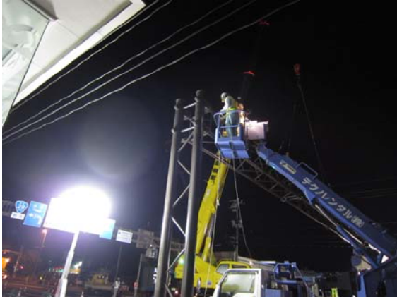
新設の柱に梁をボルトで取り付けます
