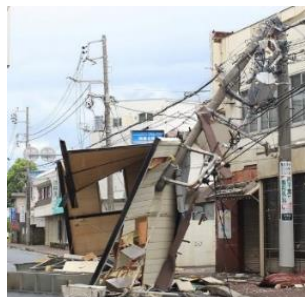
<飛来物による電柱倒壊の事例>
