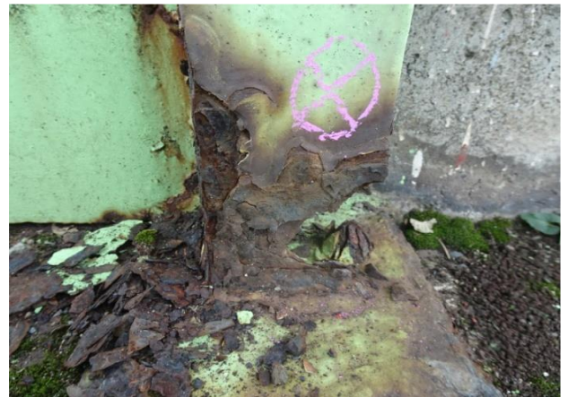
主桁の腐食
