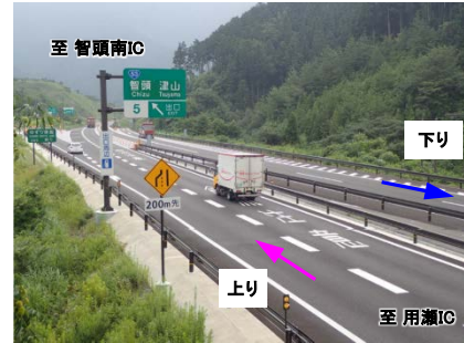
写真① 智頭IC上り線 (R2.6 完成)
