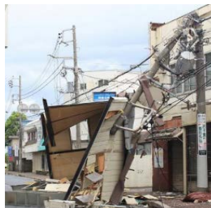
<飛来物による電柱倒壊の事例>
