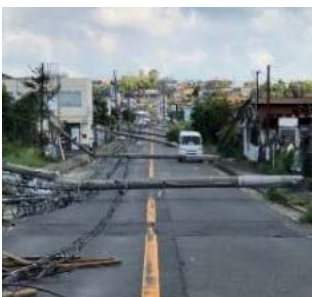
<電柱の倒壊による道路閉塞の事例>
