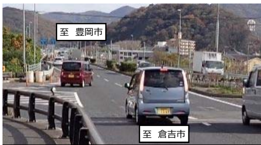
写真①：合流車線が無い場合追突の危険性がある状況
