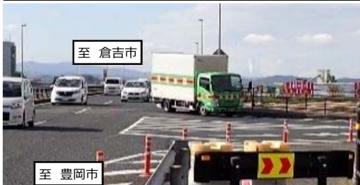
写真②：分流車線が無い場合追突の危険性がある状況
