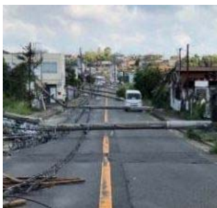
<電柱の倒壊による道路閉塞の事例>
