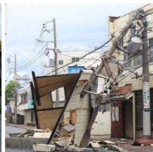
<飛来物による電柱倒壊の事例>
