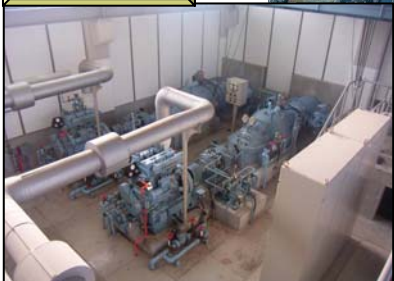
湯所川排水機場館内写真
