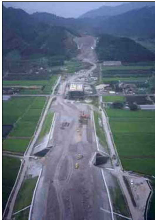
河原町佐貫付近状況写真
