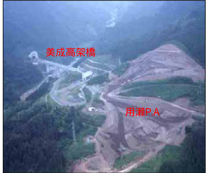
用瀬町美成付近状況写真
