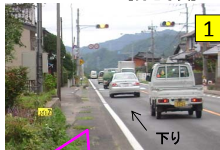
下り側歩道なし 上り側歩道W=1.0m程度
