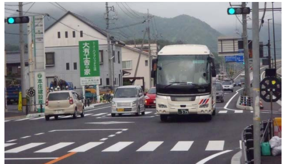
【右折レーン設置後の通行状況】(交差点西側)
