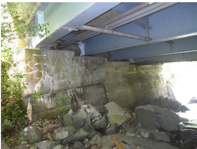
橋台のアルカリ骨材反応
