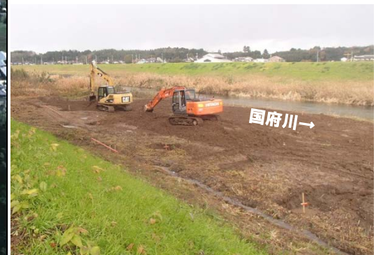
<掘削状況写真>
