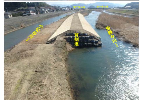
背割堤の整備状況 (新青木橋より背割堤整備箇所を望む)
