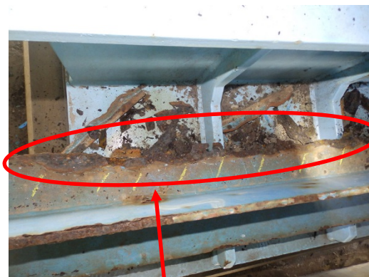
部材の断面欠損
