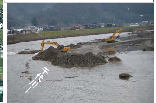
<掘削状況写真>
