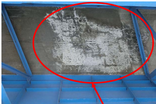
床版コンクリートのひびわれ、漏水・遊離石灰
