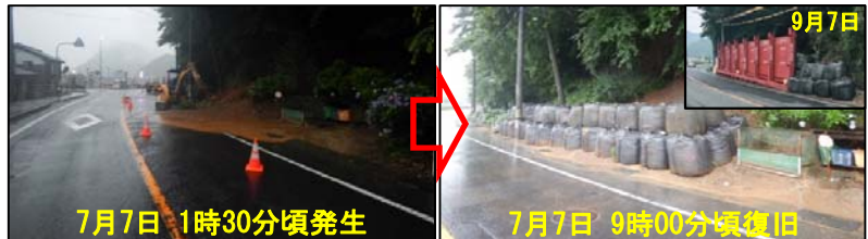
国道29号 87k740 若桜町浅井地内 (土砂流出)
