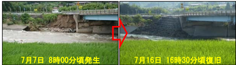
国道53号 112k860 用瀬町古用瀬 (護岸洗掘・倒壊)
