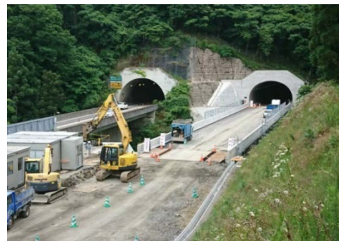
工事現場状況
