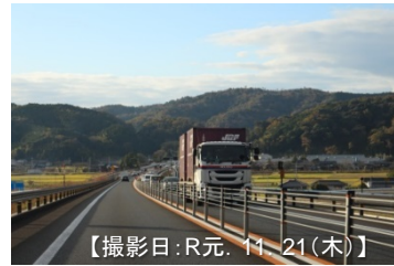
【撮影日：R元. 11. 21(木)】 鳥取西道路の利用状況
