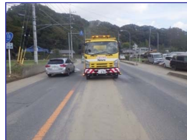
台風19号対応 路面清掃車による路面清掃作業 (茨城県久慈郡大子)
