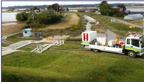
台風19号対応 排水ポンプ車による排水作業 (宮城県大崎市鹿島台)
