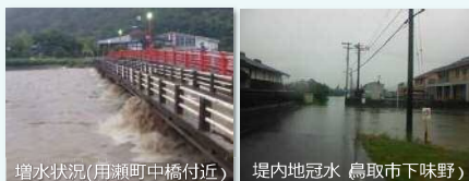
平成30年7月豪雨での被害状況
