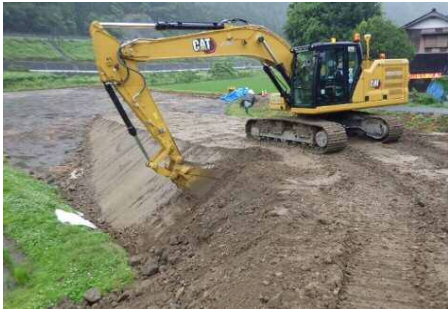
マシンコントロールバックホウによる施工
