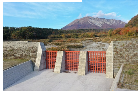
二の沢砂防堰堤(R3.11完成)
