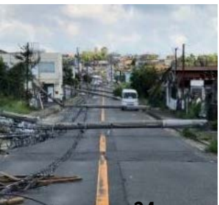
<電柱の倒壊による道路閉塞の事例>
