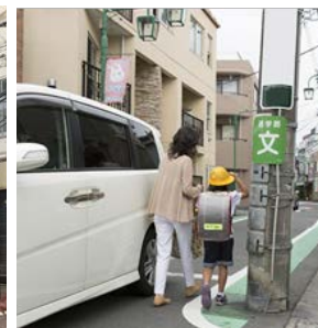
<歩行の支障となる電柱の事例>
