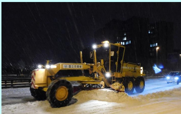
除雪グレーダによる道路除雪 (国道9号)
