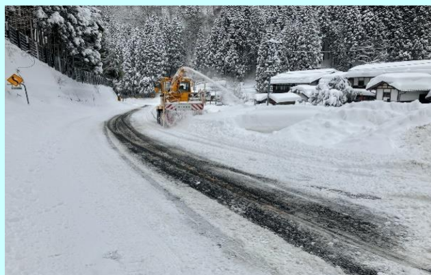
ロータリー除雪車による道路除雪 (国道29号)
