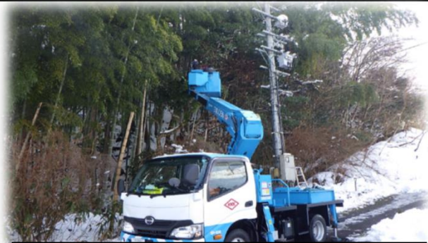
高所作業車による停電復旧 (鳥取自動車道用瀬第二トンネル)
