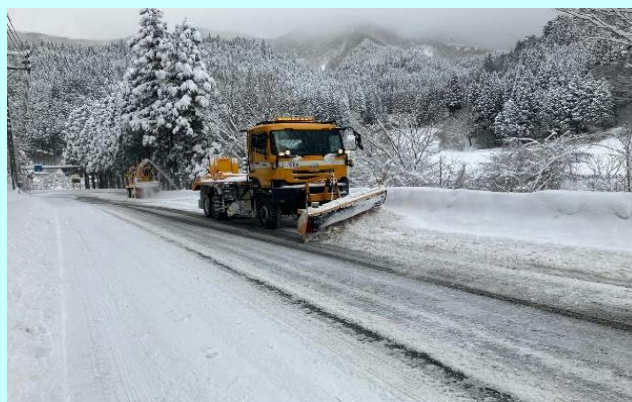
除雪トラックによる道路除雪 (国道29号)
