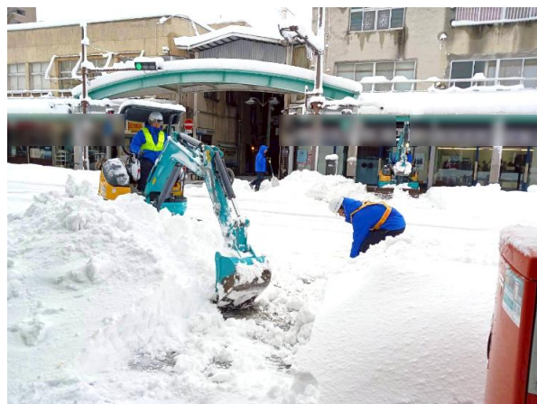
歩道除雪【鳥取市】
