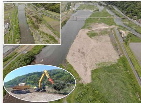
令和7年度千代川上流維持工事 (株式会社竹内組)
