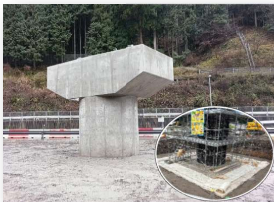
令和6年度志戸坂峠道路防災福原ランプ橋下部工事 (株式会社藤原組)
