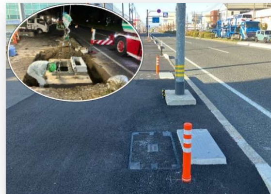
令和6年度国道29号千代水電線共同溝第4工事 (やまこう建設株式会社)
