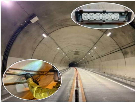
令和6年度鳥取自動車道 末宗第2トンネル外照明設備工事 (岡田電工株式会社)
