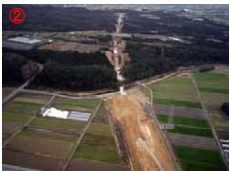
工事の進む赤碕地区 (黒川橋付近から赤碕中山ICを望む)
