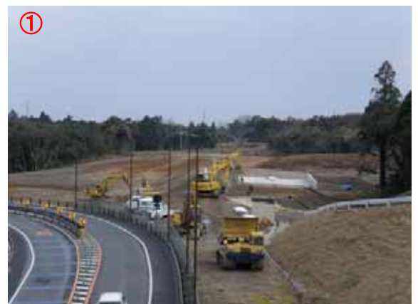
工事の進む名和IC付近 (名和ICより東を望む)
