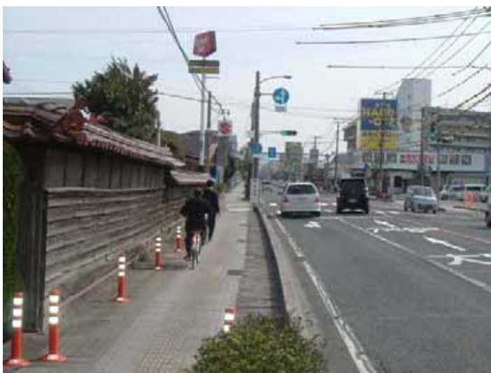
国道9号 米子市東福原地内
