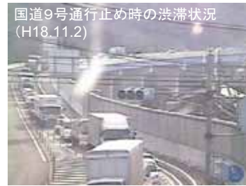
国道9号通行止め時の渋滞状況 (迂回路) 八東水トノ礼付近より西方面を望む
