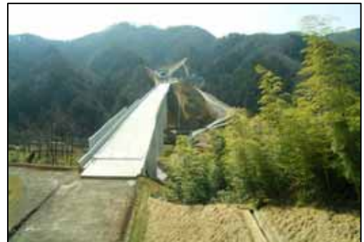
佐用～西粟倉間 美作市(中西橋付近)
