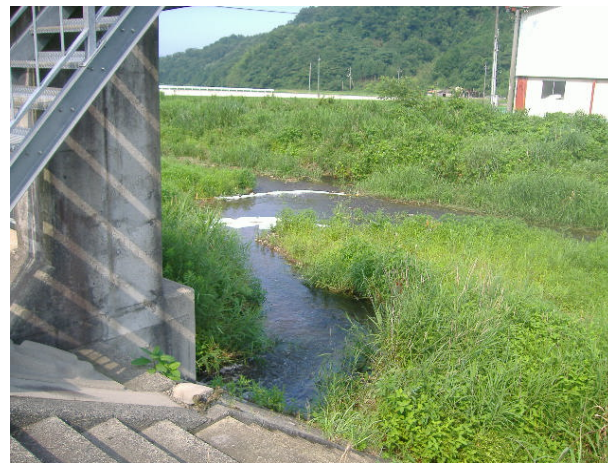
西今在家3号樋門
