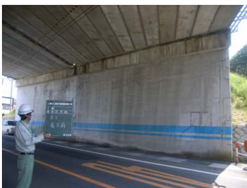
損傷状況（ひび割れ、遊離石灰）
