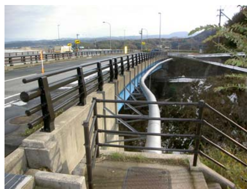
補修完了状況
