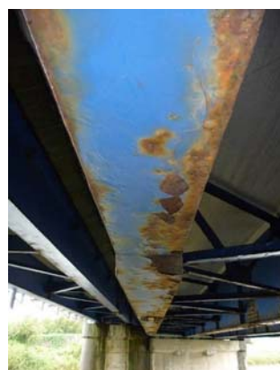
【損傷状況写真】
