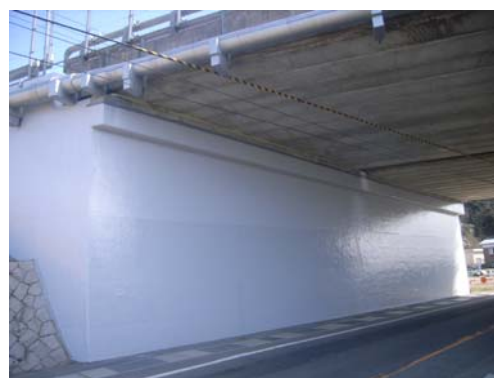
補修完了状況
