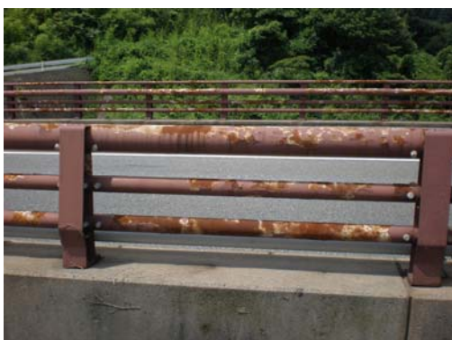
損傷状況（防食機能の劣化）
