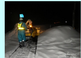
鳥取大橋付近歩道除雪状況
