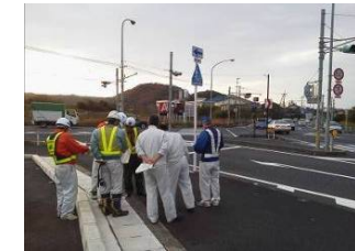
現地作業確認(溝川交差点)
