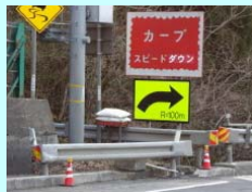
黒尾峠凍結防止材の配備
