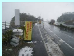
日光坂塩カル、7号採石の設置
