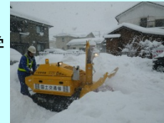
県庁付近での歩道除雪状況
