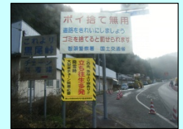
黒尾峠手前注意看板の設置
