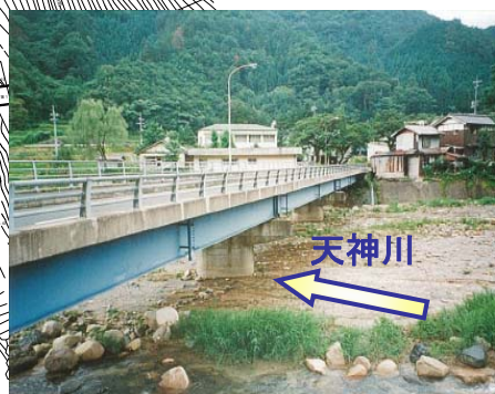
平常時（復旧後）
