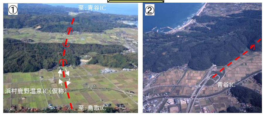
進捗状況写真
