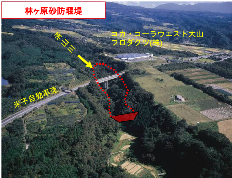
林ヶ原砂防堰堤
