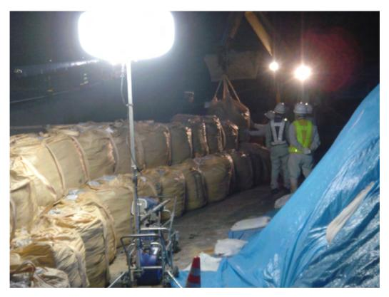
智頭 IC のり面崩落に際し、緊急的に大型土のう設置と簡易測量を実施しましら。
