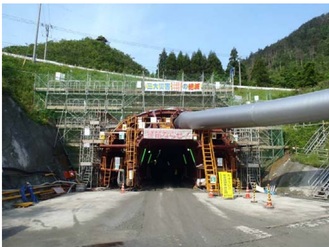
トンネル入口
