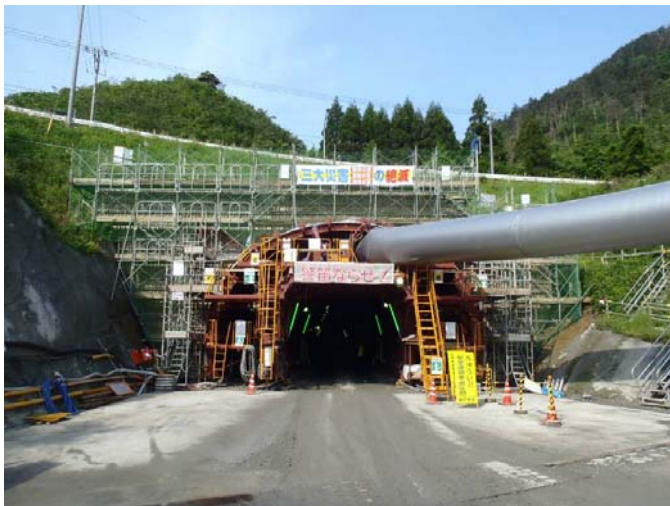
トンネル入口
