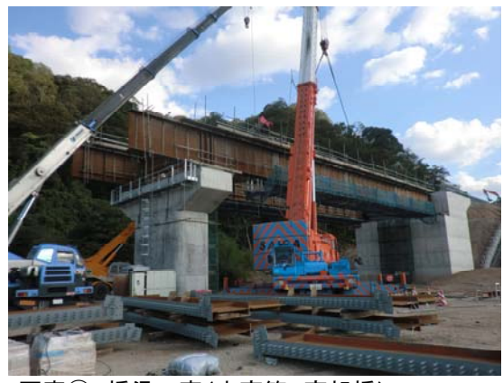
写真② 橋梁工事(本高第1高架橋)
