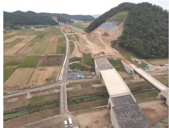
写真③ 改良工事(鳥取市本高地内)
