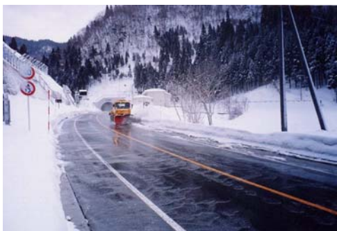
戸倉トンネル坑口付近
