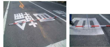
舗装のわだち掘れ
