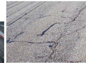
舗装のひび割れ
