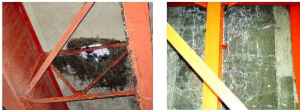
橋の裏面の様子(床版)
