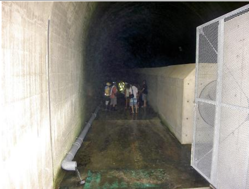
転流工（入口） 入口から奥まで約340mあります。
