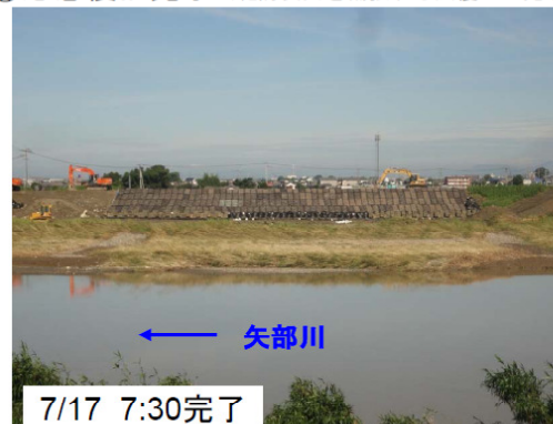
⑤応急復旧完了 (堤防表面を補強する法覆工が完了)
