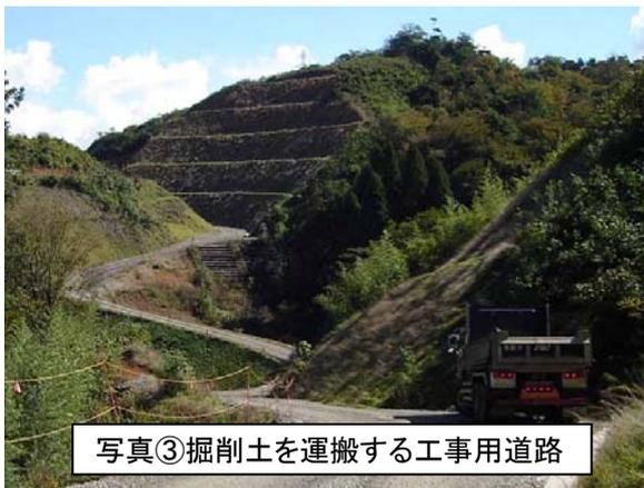
写真③ 掘削土を運搬する工事用道路
