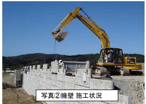
写真② 擁壁 施工状況
