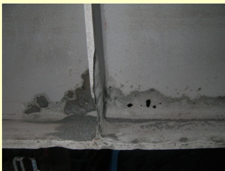
桁のあて板 補修、塗装
