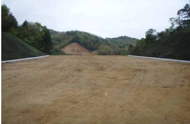
鳥取西道路桂見第3改良外工事(現況)
