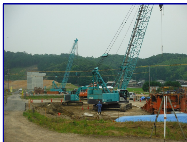
②基礎工施工状況 (P2~P5)
