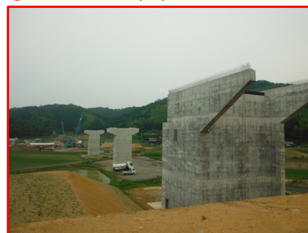
③下部工完成 (P6,P7,A2)
