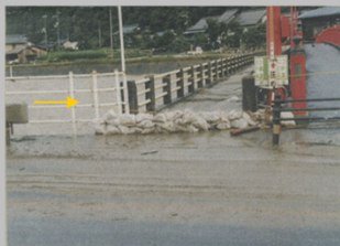
平成10年10月洪水 溢水した国道53号(用瀬町)
