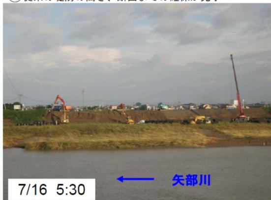
⑤応急復旧完了 (堤防表面を補強する法覆工が完了)
